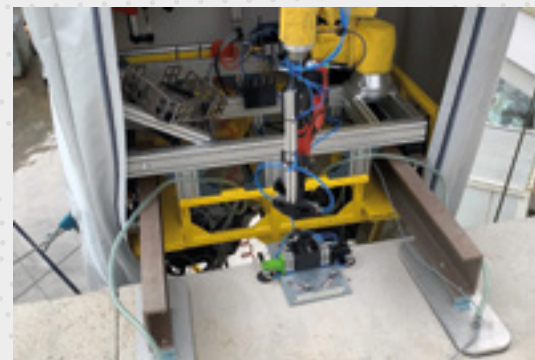
05 End-effector instalando los anclajes del muro cortina.
